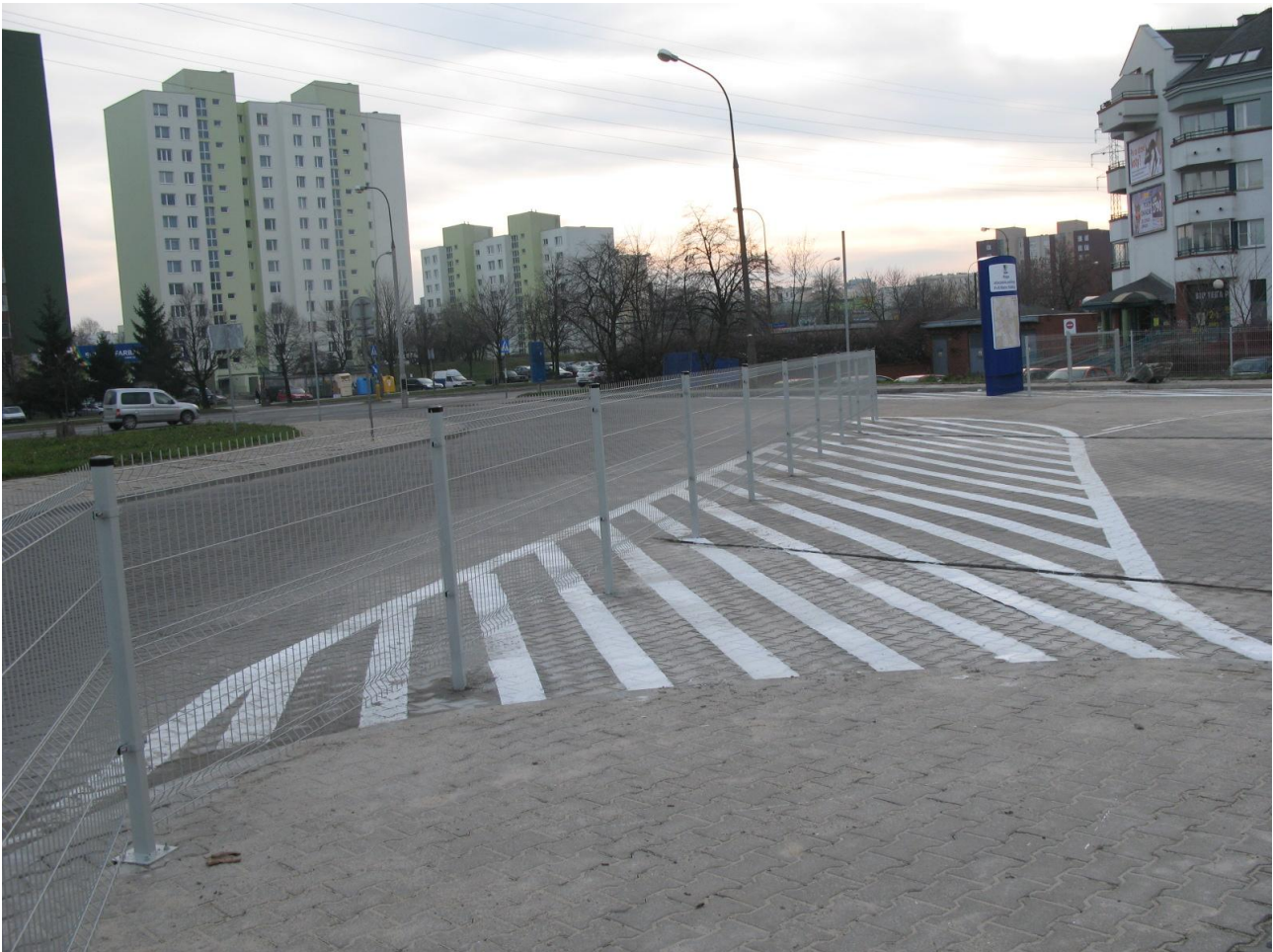
Fot. 2 - Wjazd na pętlę autobusową "Ursynów Południowy"
